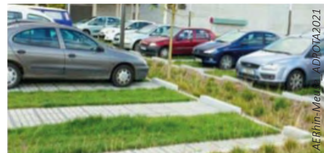
Noue végétalisée avec infiltration gravitaire du ruissellement, et aménagement favorable aux mobilités douces
